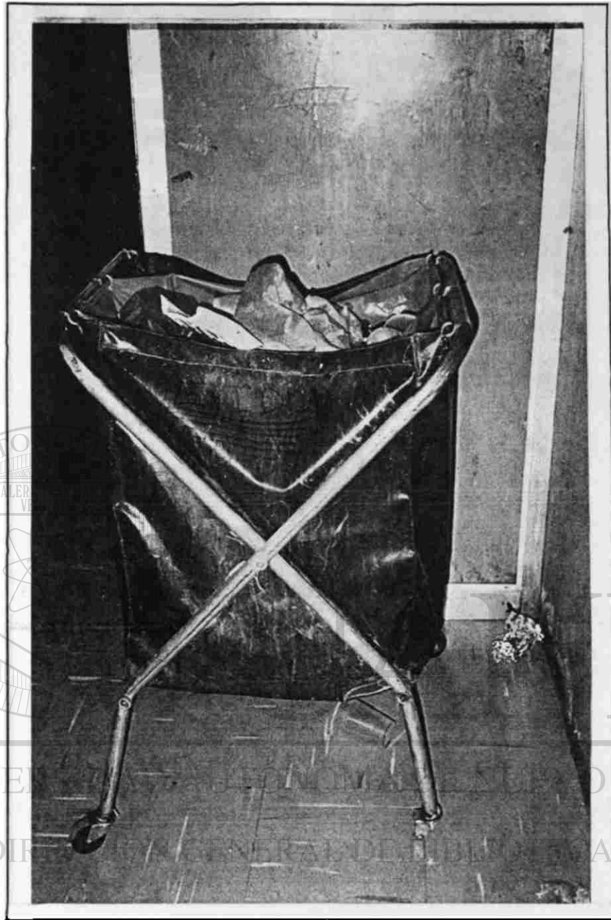
FOTO 11. CARRO RECOLECTOR DE RESIDUOS SOLIDOS. Se observan bolsas de diferente color, y el carro en malas condiciones de operación y con una capacidad de llenado mayor del 85%.
