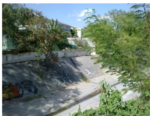
Foto 4.6. Modificaciones a la vivienda después de inundación. San Bernabé
