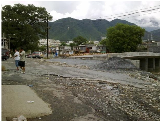
Foto 4.9. Col. San Ángel Puente destruido por inundación
