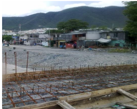
Foto 4.10. Viviendas expuestas y de propiedad irregular
