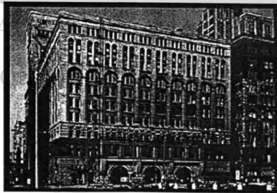
i) Edificio Auditorio, en Chicago.
