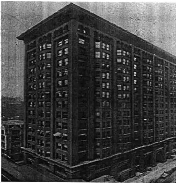
Fig. 1.34 Edificio Monadnock , en Chicago.
