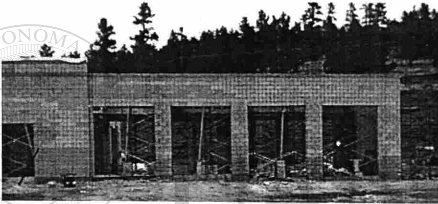
Fig. 3.1 Construcción de vigas y dinteles de mampostería.
