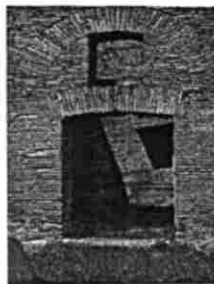
Fig. 1.26 Arco romano construido con ladrillos.
