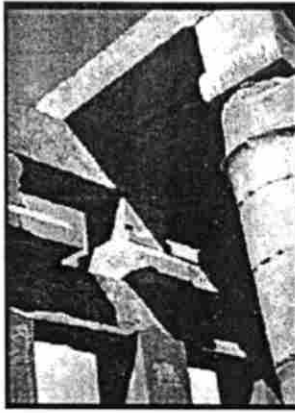
Fig. 1.12 Detalles de elementos estructurales antiguos.
