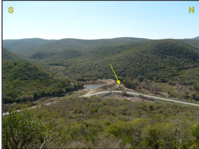
Fig. 3.1 Vista panorámica hacia el oeste, se indica la sección de San Nicolás.
