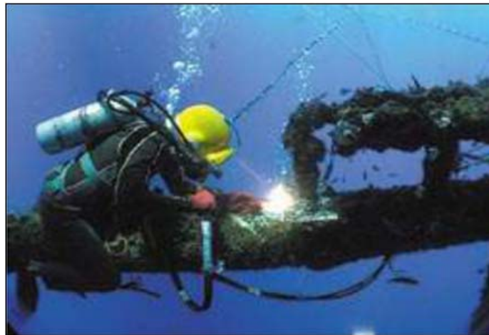
Figura 2.1. Proceso de soldadura submarina (MMA) realizada por un buzo.
