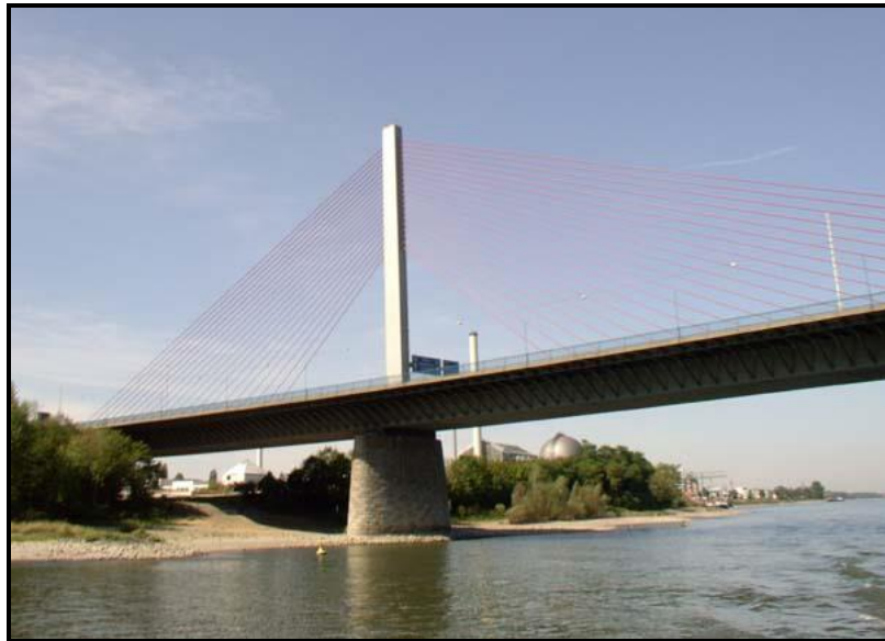
Fig. 2.15 Puente Friedrich Ebert, Alemania, 1967
