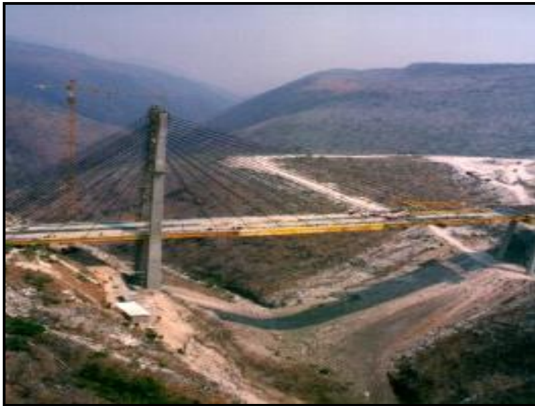
Fig. 2.5.13 Puente Barranca del Cañón, 1993
