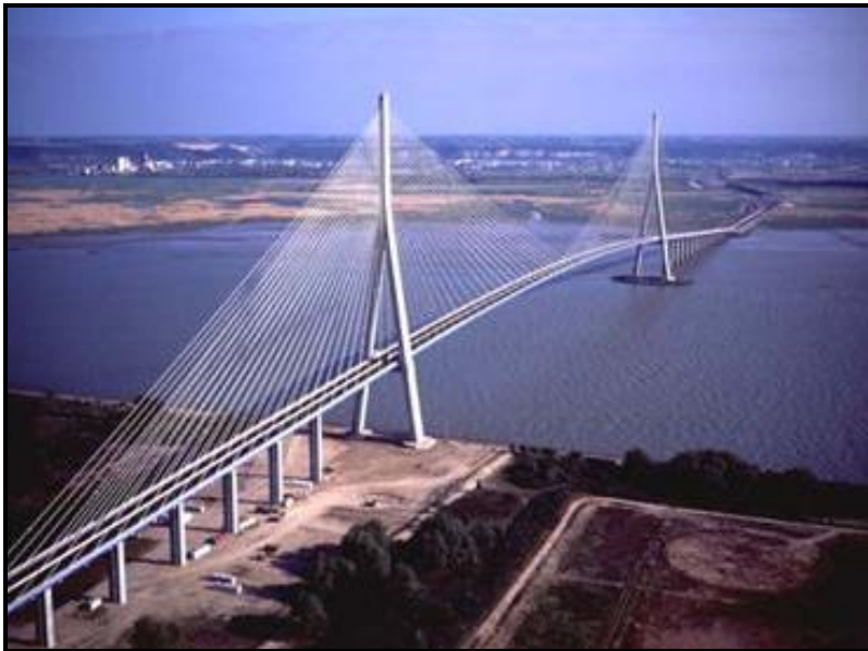
Fig. 2.16 Puente de Normandia, Francia 1995
