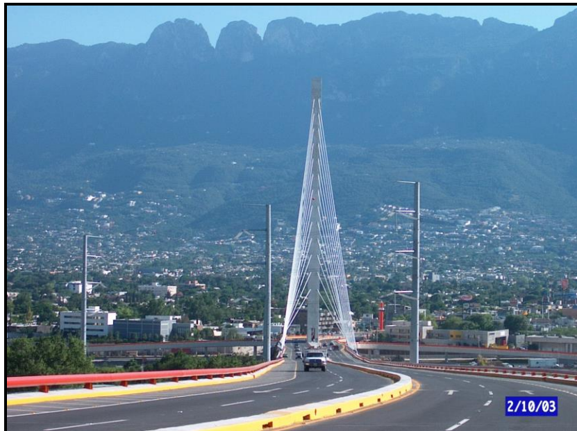
Fig. 2.5.8 Tirantes del Puente
