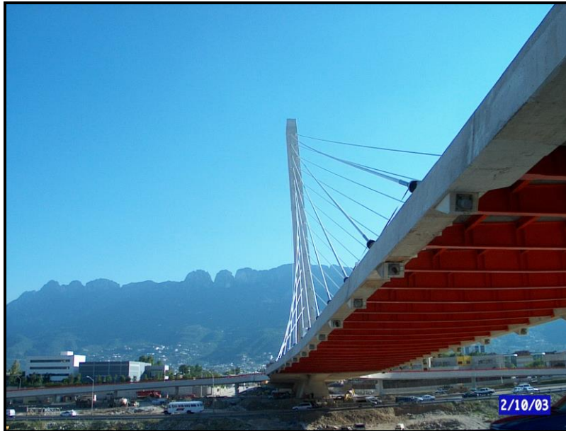
Fig. 2.5.7 Tablero del Puente de la Unidad en su claro principal
