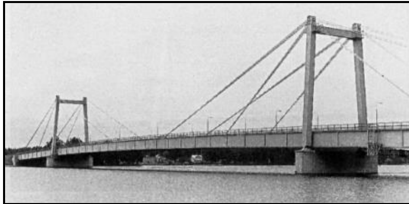
Fig. 2.11 Puente Strömsund, Suecia, 1955
