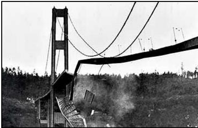
Figura 1.5 Falla por Inestabilidad Aeroelástica puente Tacoma Narrow
