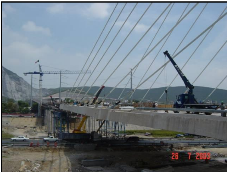
Fig. 7.10 Puente en etapa de construcción (vista S-N)
