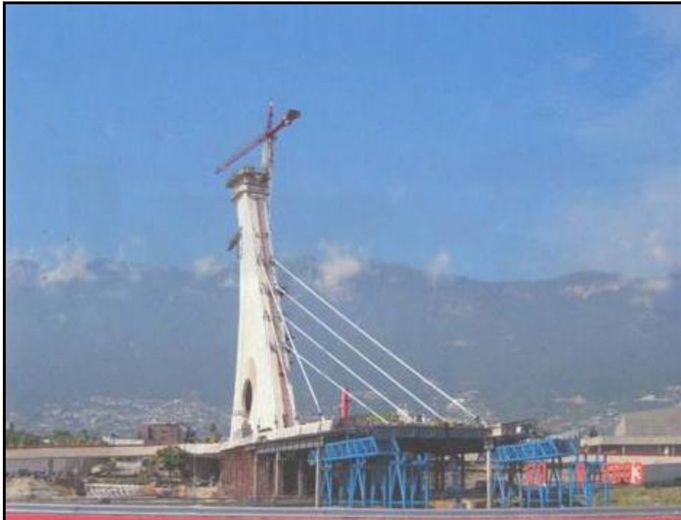
Fig. 7.8 Puente en etapa de construcción
