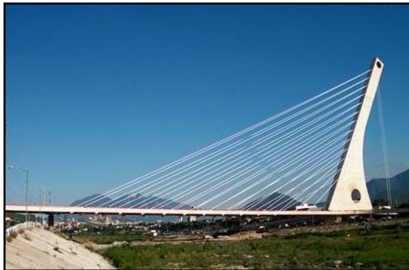
Figura 1.3 Puente sobre el Río Santa Catarina, Monterrey, Nuevo León
