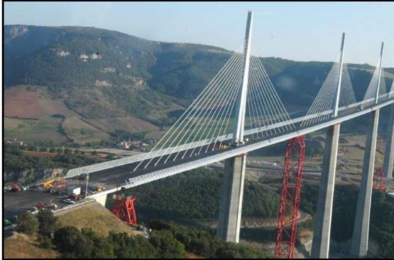
Fig. 2.18 Viaducto de Millau
