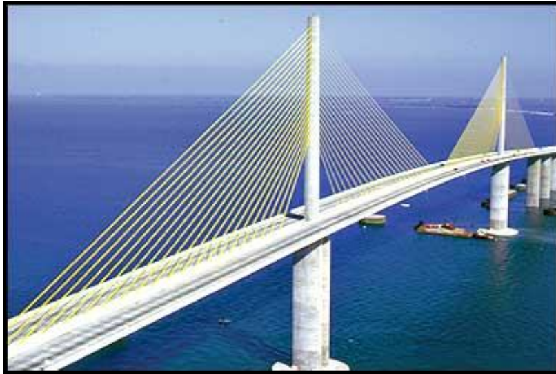
Figura 2.27 Puente Sunshine Skyway en Florida, USA
