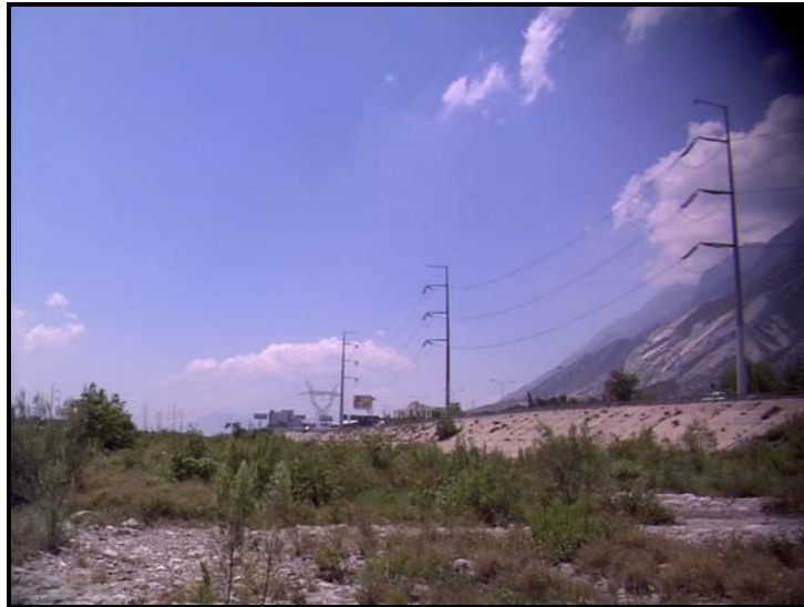
Fig. 7.18 Sitio donde se construirá el Puente (vista al N-W)
