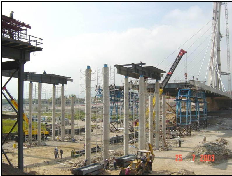
Fig. 7.9 Puente en etapa de construcción (vista N-S)
