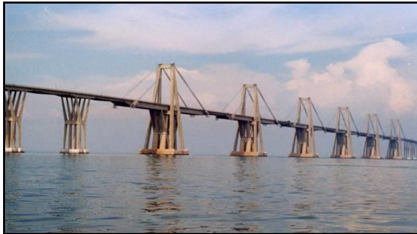
Fig. 2.14 Puente Maracaibo, Venezuela, 1962
