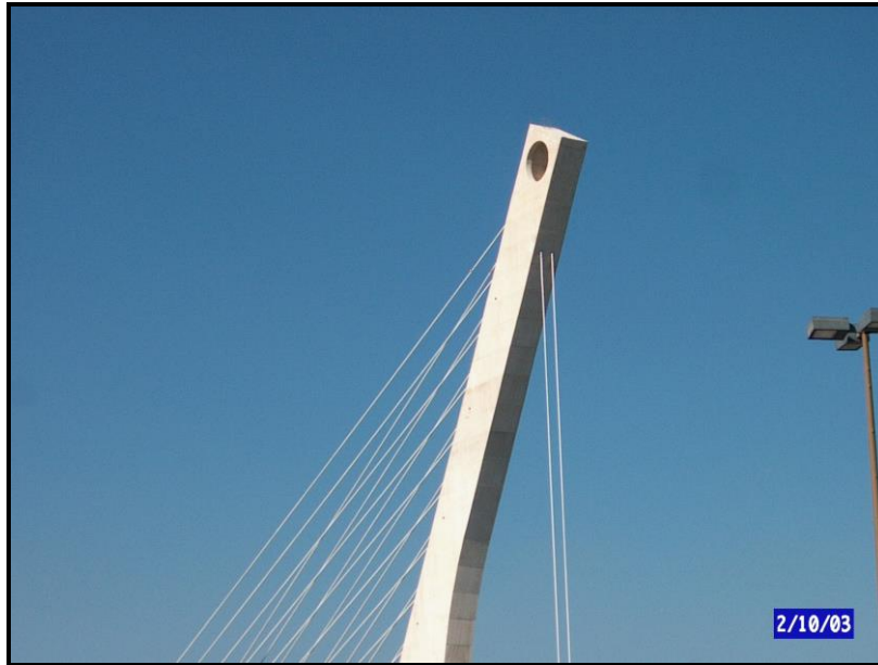
Fig. 2.5.9 Cables posteriores del mástil
