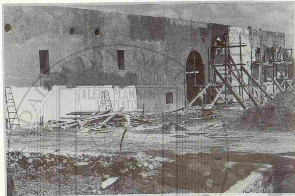
Otro aspecto del comienzo de la obra
