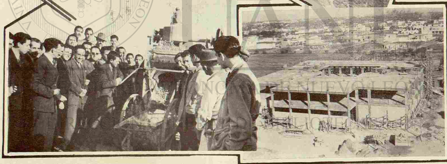
El Gobernador del Estado Lic. Arturo B. de la Garza y el Director de la Facultad Dr. Roberto Treviño Martínez en la colocación de la primera piedra del actual edificio y vistas de su desarrollo.
