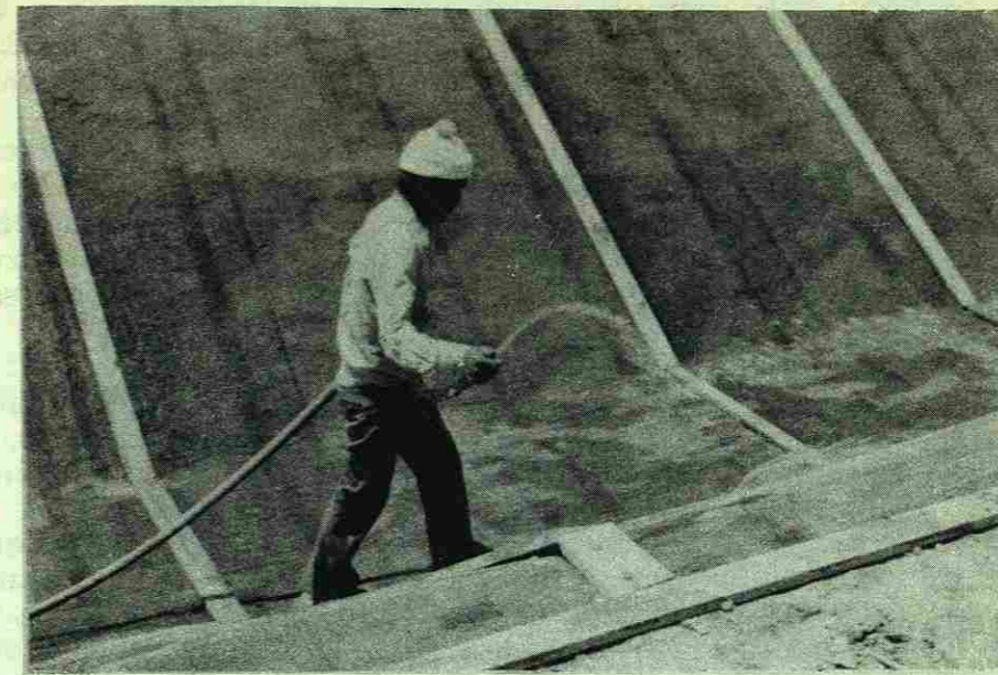
Fig. 23.- Humedecimiento del terreno antes del colado.
