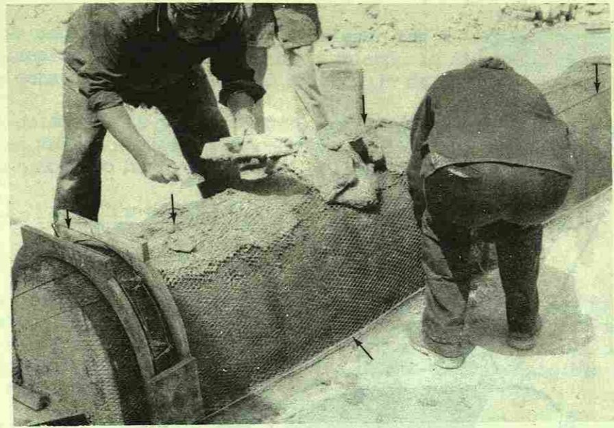
Fig. 36.- Colado final de la canaleta.
