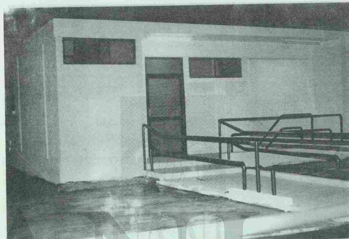
Construcción de sala de Maestros
