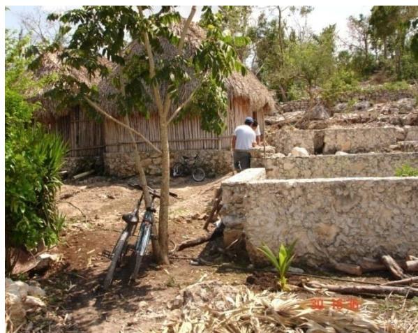
Figura 10. Casas del municipio de Lázaro Cárdenas, Quintana Roo.
