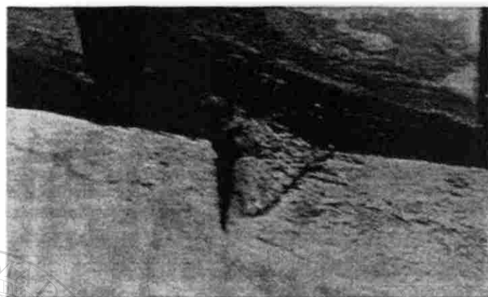
Fig. 6.11.12 Estrias por lavado en una cubierta de acero de un diafragma de un anillo externo.
