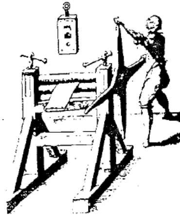
Fig. 4.5. Molino construido por Salomón de Caus para laminar plomo (25).
