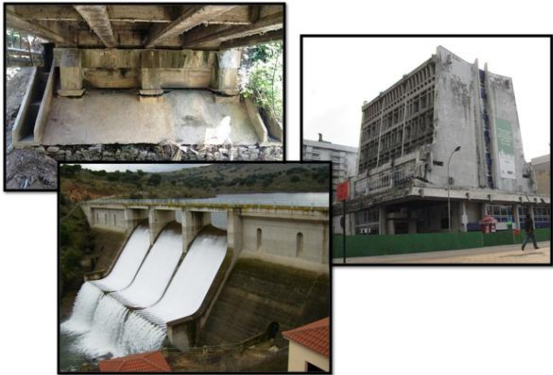
Figura 1. 9 Infraestructura que presentan problemas de deterioro.
