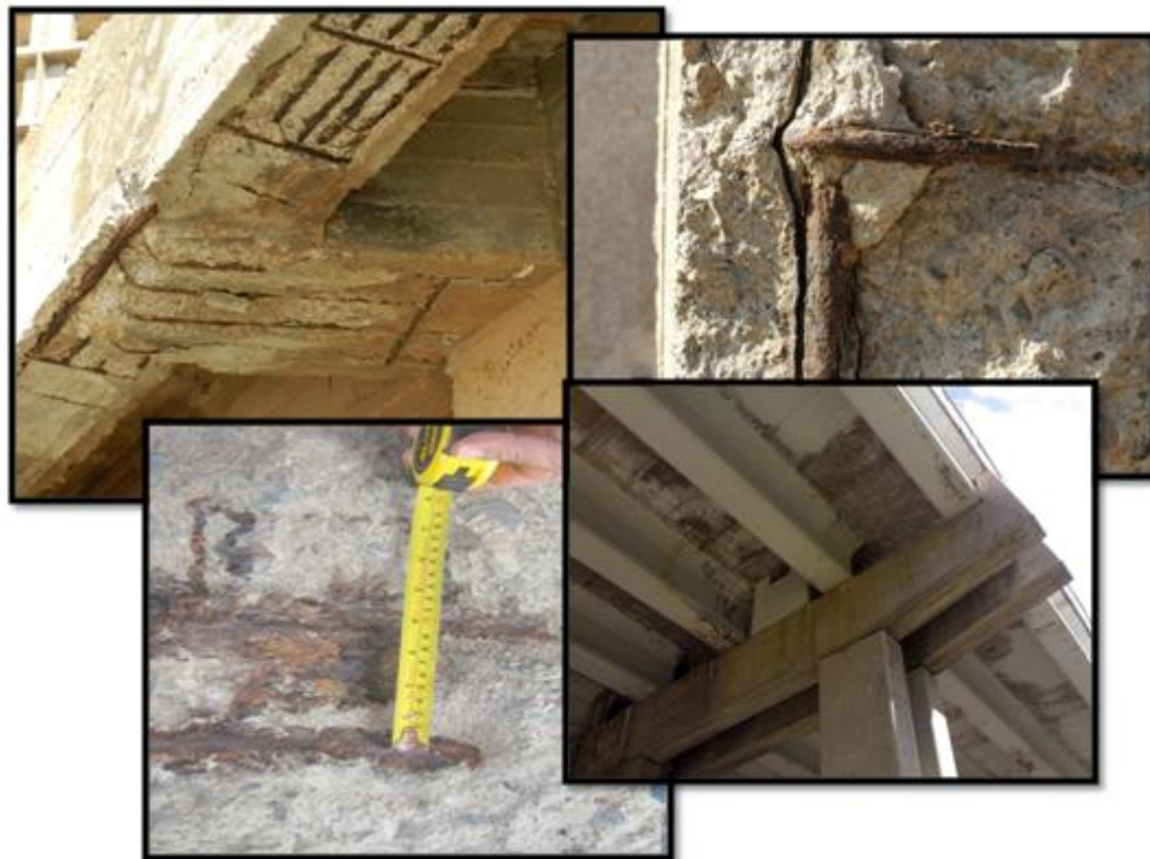
Figura 1. 10 Manifestaciones de la problemática de la corrosión en el concreto en obra civil.
